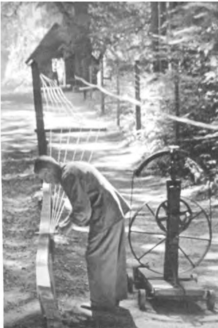
*Die Herstellung langer Seile im Freien, der Seiler bereitet die einzelnen Litzzen, für die Aufnahme auf dem Seilergeschirr, rechts im Bild, vor. Die Litzzen kommen in drehbare Haken, die über ein Rädergetriebe gleichzeitig gedreht werden und so die Litzzen miteinander verdrillen.*
