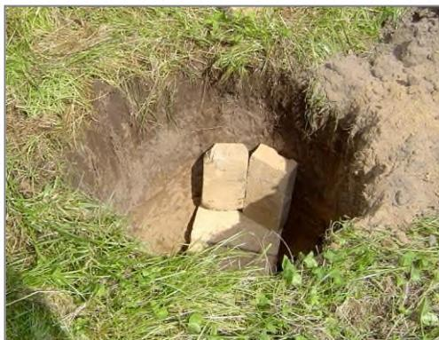
Der Trockenprozess für eine Auskleidung aus Lehm dauert im feuchten Boden sehr lange, mindestens drei bis vier Tage. Deshalb wurden in diesem Fall für den Boden und die Seiten ungebrannte, luftgetrocknete Steine in Ziegelform aus Lehm verwendet und mit frischem Lehm ausgefugt.
