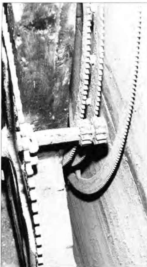
Abb. 15 Die Zahnräder F; E; G mit 228; 236; bzw. 365 Zähnen zwischen Uhrscheibenrückwand und Werkgestell geben weder Raum noch irgend einen Hinweis auf das hypothetische Rad mit 366 Zähnen.
