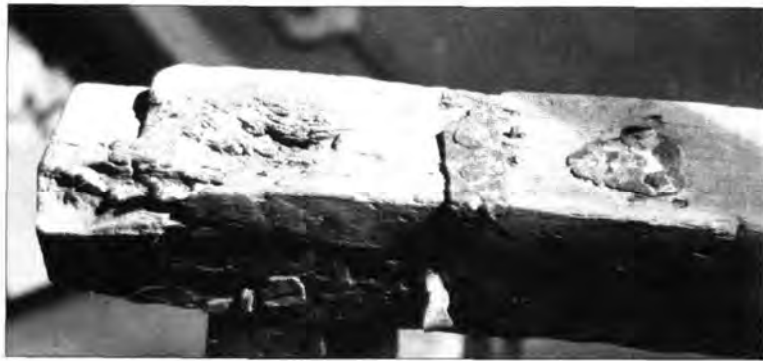
Abb. 16 Reste und Spuren ehemaliger Befestigungen an Balken XIII: Reste der oberen Halte- rung bzw. Aufhängung der Spindel.
