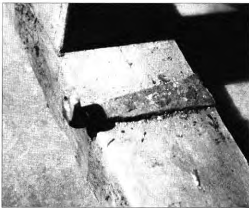
Abb. 8 Lager der fehlenden Welle IV (siehe Abb. 5 und 9): a) Lagerauge an der hinteren Fläche von Balken II (vergleiche dazu auch Abb. 21); b) Lagergabel an der hinteren Fläche von Balken I.
