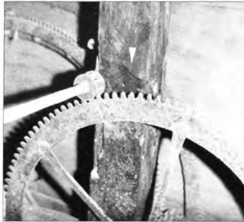
Abb. 19 Spuren der Befestigung einer ehemaligen Haltelasche an Balken IV in Höhe der Bohrung. Eine analoge Kerbung mit Nagellöchern befindet sich auch an Balken III.
