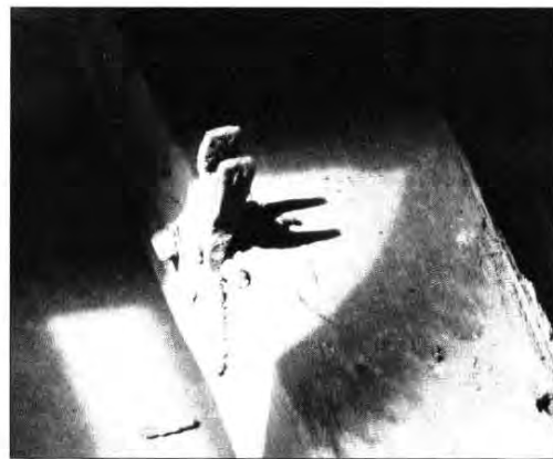
Abb. 8 Lager der fehlenden Welle IV (siehe Abb. 5 und 9): a) Lagerauge an der hinteren Fläche von Balken II (vergleiche dazu auch Abb. 21); b) Lagergabel an der hinteren Fläche von Balken I.
