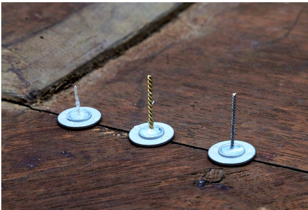
Die Drähte, mit denen die Karbonplatten auf der Kalenderscheibe befestigt sind, wurden durch Spalte zwischen den Brettern der Kalenderscheibe geführt und von unten verklebt Quelle: Edeltraud Altrichter
