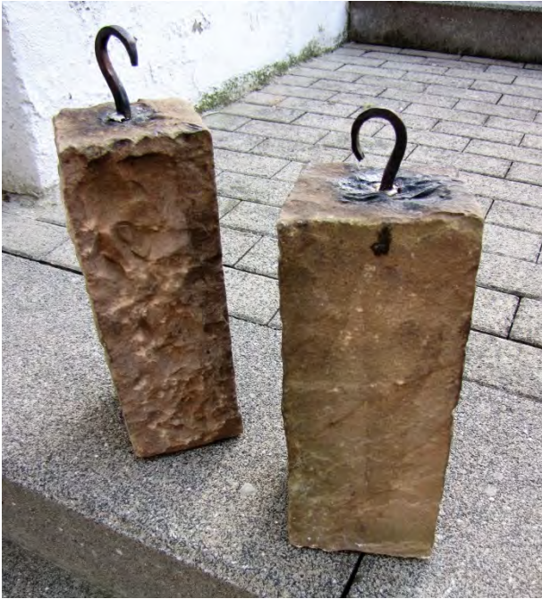
Vorhandenes Sandsteingewicht, 300mm x 120mm x 120mm, ca. 10Kg, dient nur zu Vorführungszwecken. Geschmiedete Öse mit Blei eingesetzt.
