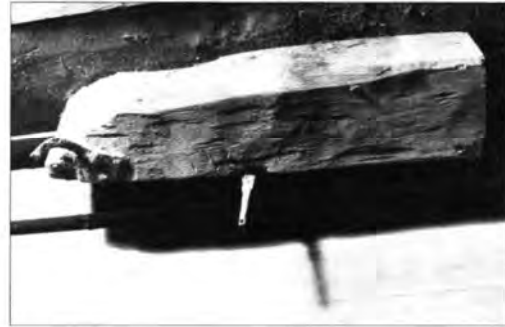
Abb. 28 (oben links) Das Bodenloch von unten. Deutlich ist die Abschrägung zu erkennen. In der helleren Fläche (= Uhrenscheibenrückwand) ist eine Einkerbung vorhanden.
