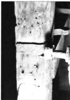
Abb. 20 Nagellöcher an der rechten Seite von Balken III, oberhalb und unterhalb des geschlossenen Lagers von Walze W1.
